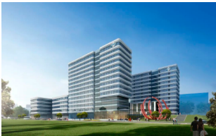
东华软件副中心产业园项目
